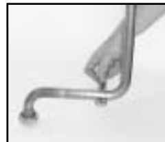
Figure 4 Entrée de l'eau glycolée
